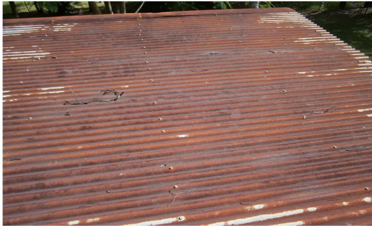
Rusted roofing iron.
